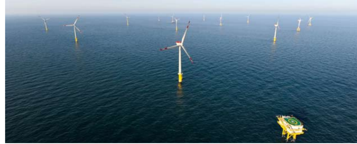
Offshore-Windkraftanlagen sind besonders leistungsfähig, aber die Wartung ist aufwendiger.
